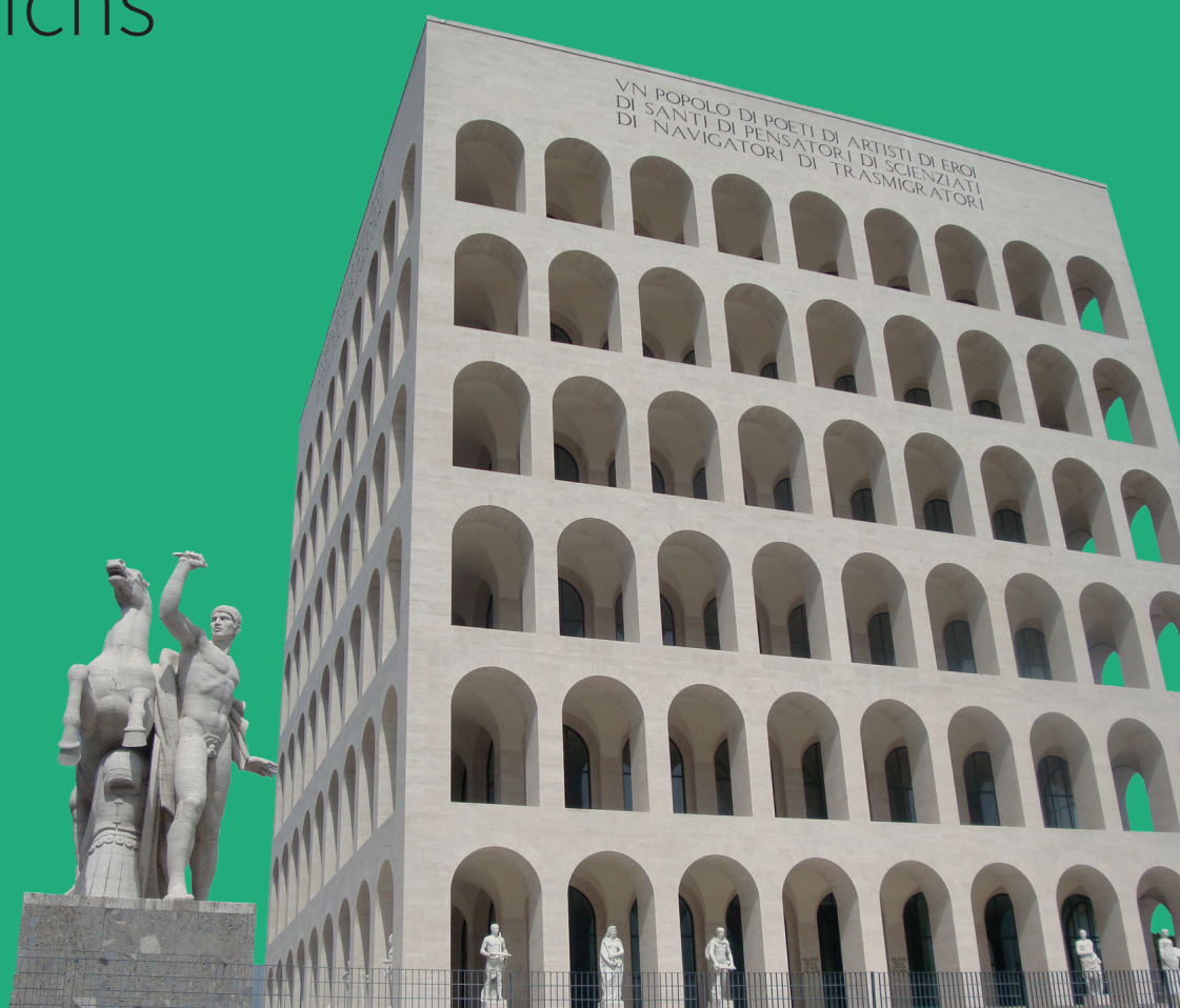
Fig.: Rom, EUR, Palazzo della Civiltà Italiana (Foto Eberhard J. Nikitsch).
